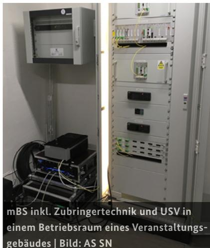
mBS inkl. Zubringertechnik und USV in einem Betriebsraum eines Veranstaltungsbauwerks | Bild: AS SN
