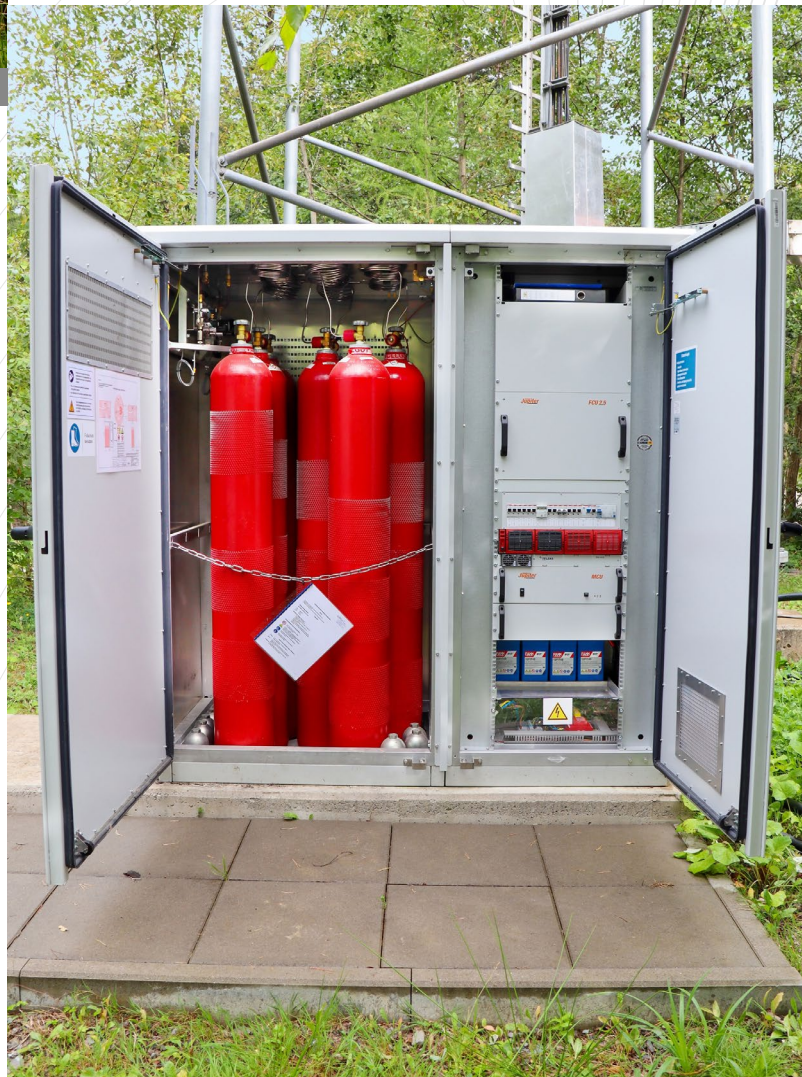
wasserstoffbetriebene Netzersatzanlage
